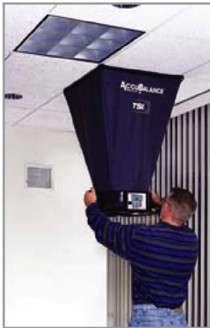
アネモ吹出、吸込測定例
